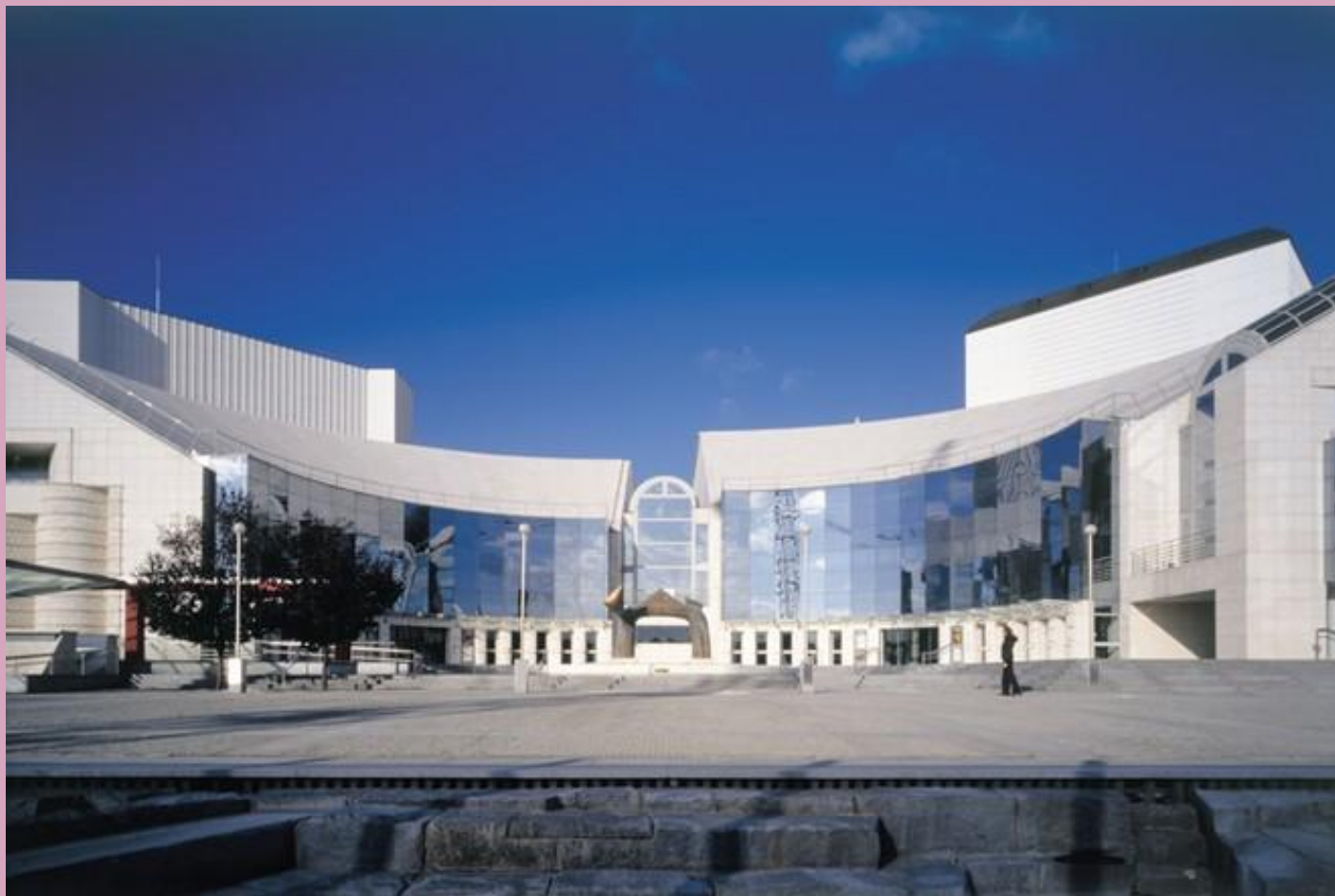
Priečelie novej budovy SND (Pribinova), Architekti Bauer, Kusý, Paňák. Archív BKPŠ
